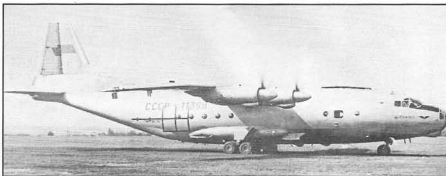
Испытания опытного образца Ан-12ПС. Под крылом самолета — крепления кинокамер, на бортах нанесена разметка для траекторной киносъемки сбрасываемых объектов
